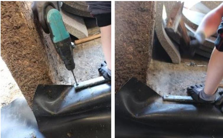
Wenn die Leiste so geschnitten wurde, dass sich am Ende kein Loch befindet, ist es wichtig, ein neues Loch zu bohren, damit die Leiste ordentlich am Ende befestigt werden kann.
