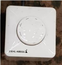
Die Ventilatorgeschwindigkeit ist mit einem Potenziometer regulierbar.
